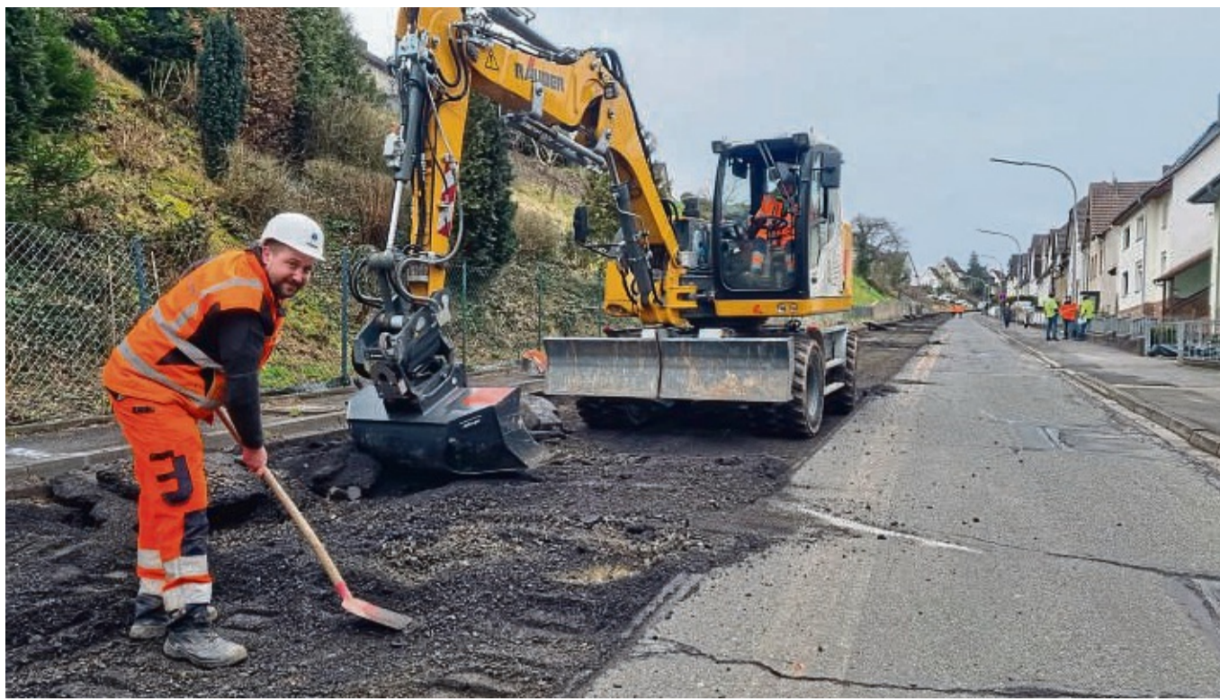
Mit Mensch und Maschine: Auf der Meisebacher Straße in Bad Hersfeld haben am Mittwoch die umfangreichen Bauarbeiten begonnen. Unser Bild zeigt vorn Polier Magnus Buchmann von der Baufirma Räuber. FOTO: NADINE MEIER-MAAZ
