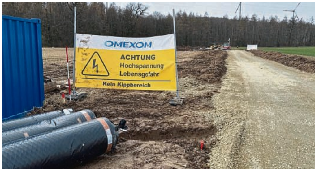
Baustelle unter Hochspannungsleitung: Später, wenn der Anschluss ans öffentliche Netz erfolgt, ist Vorsicht geboten.
