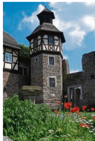
Prägnante Silhouette: Der Glockenturm prägt die historischen Bauten in Wülmersen. FOTO: THIELE
