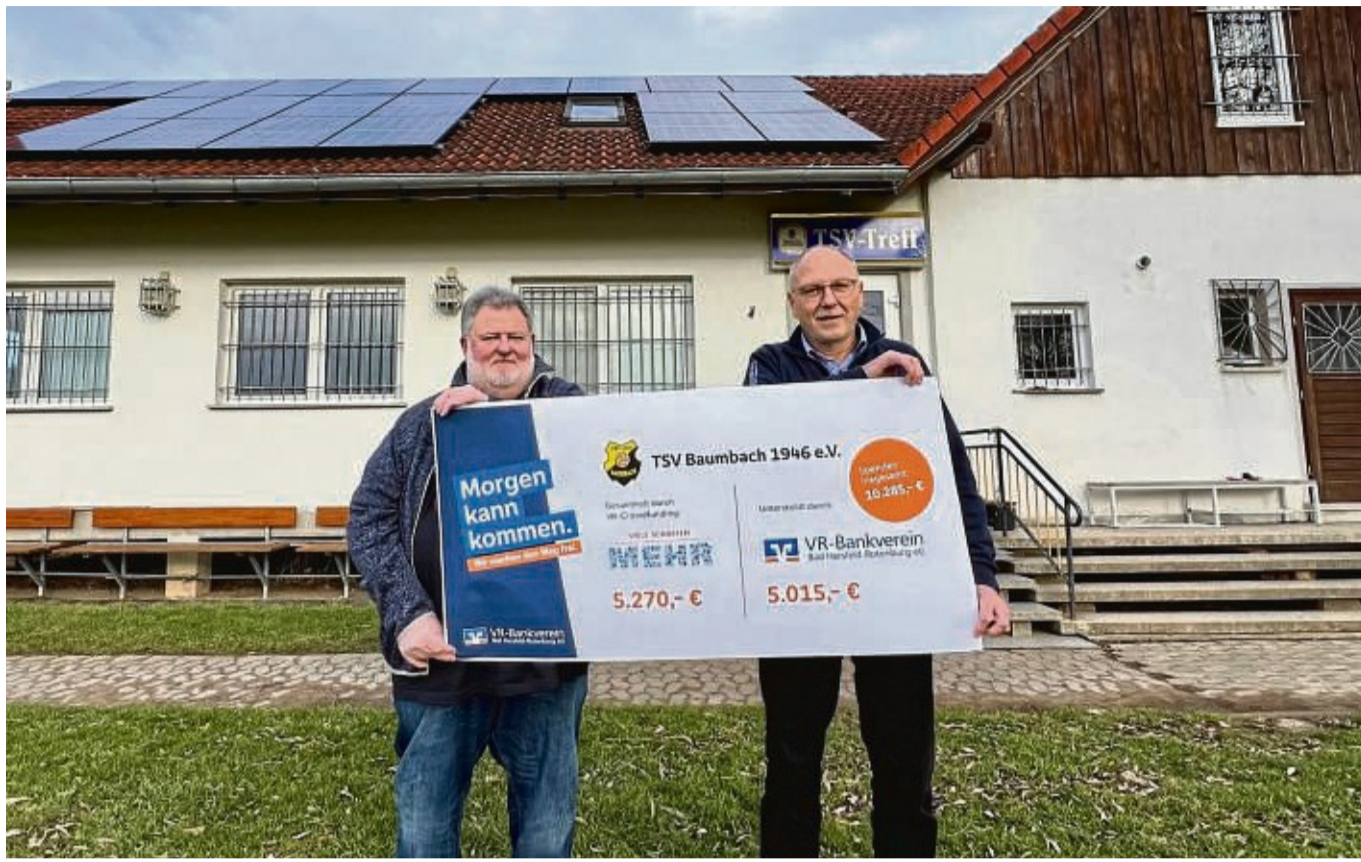
Der TSV Baumbach hat auf dem Dach seines Sporthauses eine PV-Anlage installiert. Das Bild zeigt den Vorsitzenden Roland Krug (links) mit Harald Mähler, Regionalmarktleiter des VR-Bankvereins.
