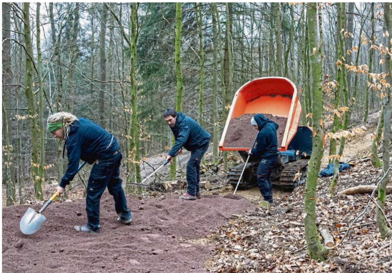
Zuwachs für die Green-Trails: Der Streckenbelag wird auf dem Themen-Trail am Diemelsee aufgebracht. Der Transport des Materials erfolgt mit leichtem Gerät, die Verteilung per Hand.
