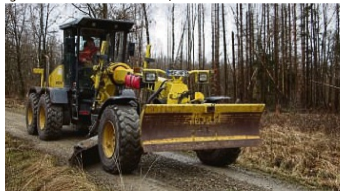
Ein Motorgrader verteilt den von einem Lkw geschütteten Schotter und stellt mit mehreren Überfahrten ein rundes, uhrglasartiges Wegeprofil her. FOTO: HESSENFORST HOLGER PFLÜGER-GRONE/NH
