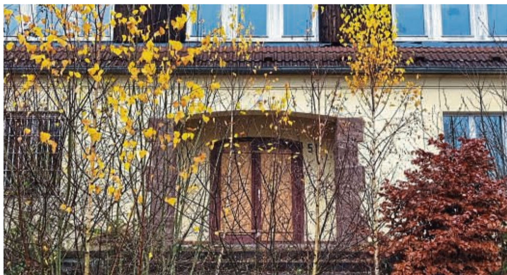
Die symmetrische Architektur der Gebäude der ehemaligen Pommernkaserne soll erhalten bleiben.
