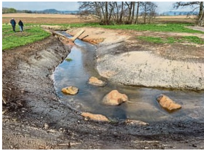
Störsteine und Altholz sollen im neuen Bachlauf der Watter eine dynamische Eigenentwicklung fördern.
