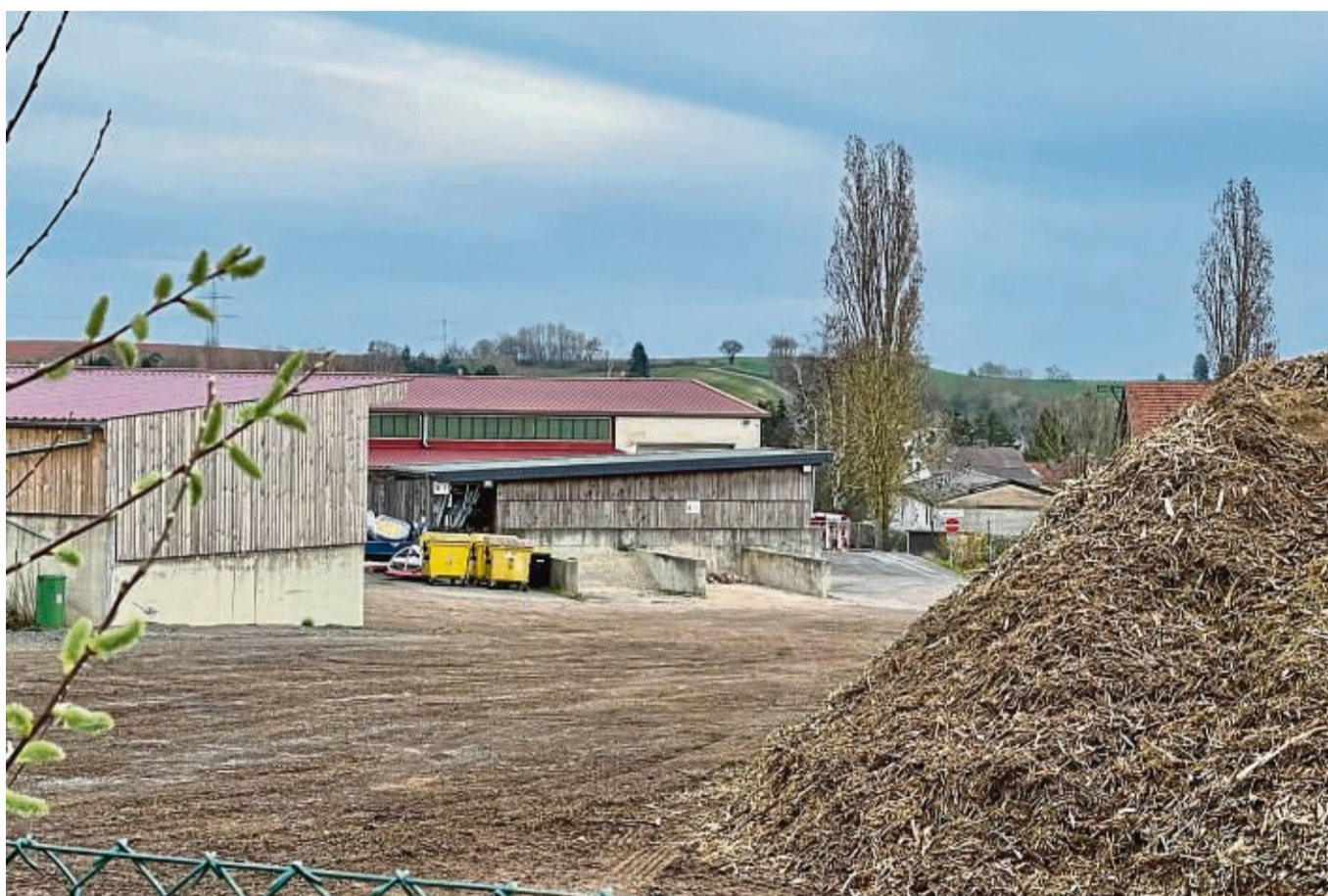
Den Sperrvermerk für weitere Planungsleistungen für den Umbau des städtischen Bauhofs in Sachsenhausen hat die Stadtverordnetenversammlung noch nicht freigegeben.
