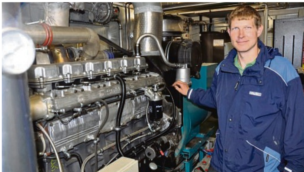
Christian Grünhaupt am Gasmotor, der Strom produziert. Die Abwärme soll in ein Nahwärmenetz fließen.
