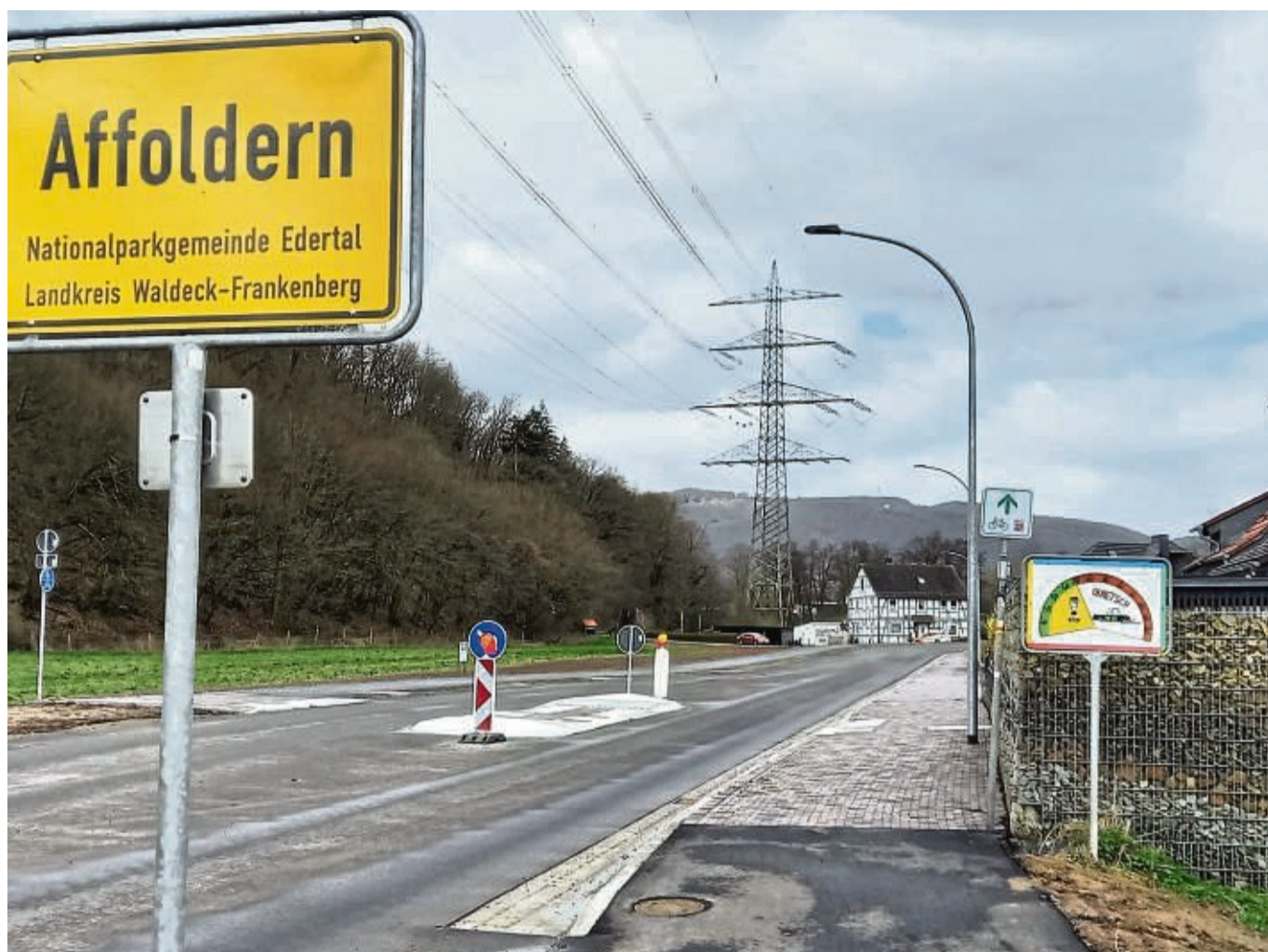
Die Landstraße 3086 zwischen Mehlen und Affoldern ist wieder frei. In der Bildmitte die neue Verkehrsinsel und links davon die neu angelegten 150 Meter Radweg Richtung Nationalparkeingang Affoldern. FOTO: SCHULTZ
