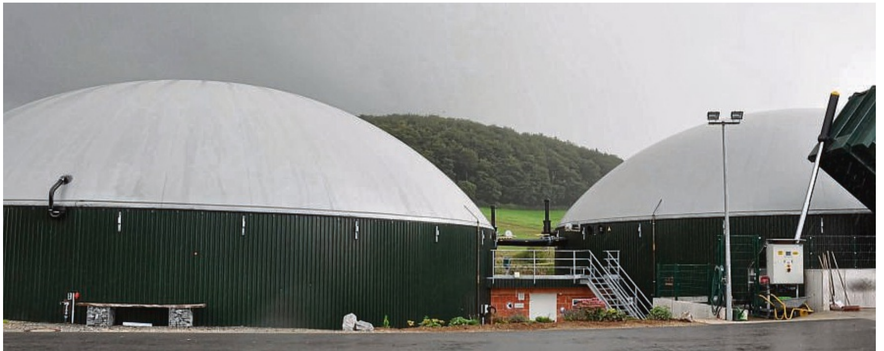
Seit 2011 produziert die Biogasanlage von Christian Grünhaupt bei Helmighäusern Strom und Wärme.
