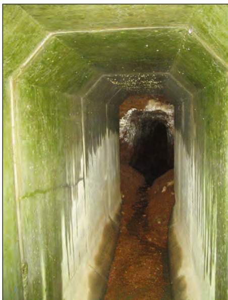
Fertigbetonteile am Stollenmundloch. Foto: Ernst-Heinrich Meidt
