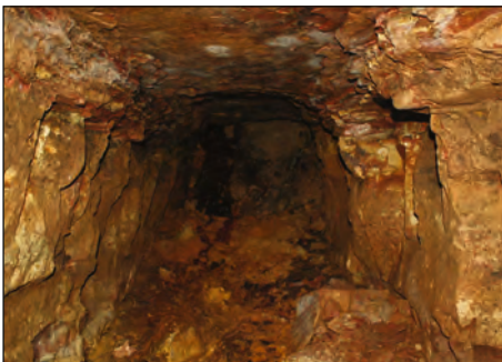
Versturz am Stollenende.
