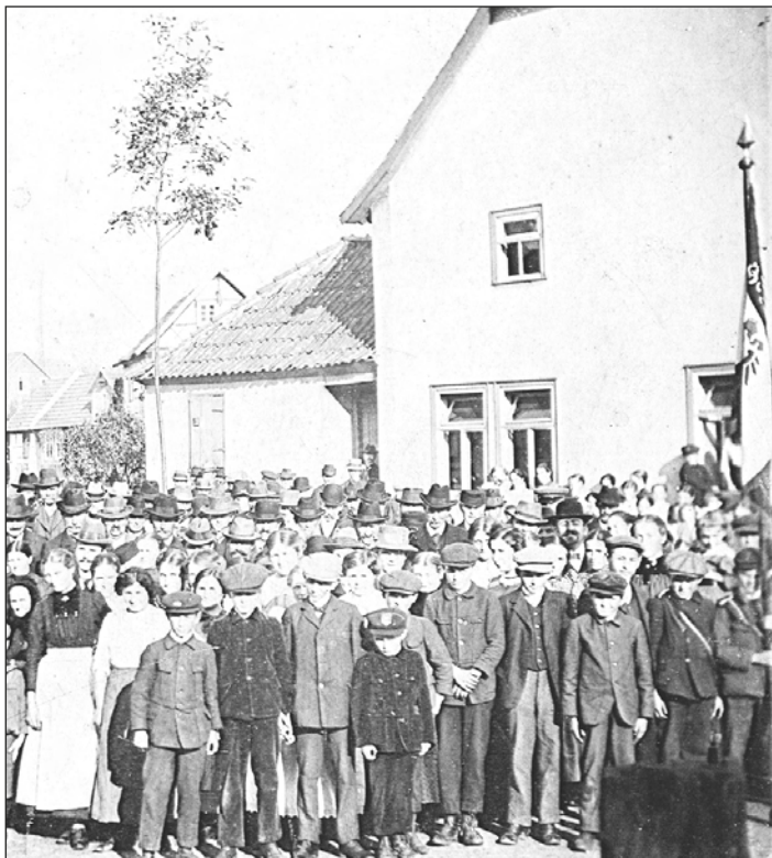
Feier 1913 anlässlich der Pflanzung einer Friedenseiche – rechts die westliche Ansicht des Synagogenbaus mit den Schulfenstern und dem Mikweanbau. (Archiv Billing)
