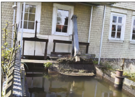
Der Mühlgraben fließt direkt ins Kellergeschoss – früher auf das Mühlrad, seit 1935 auf die Turbine. (Foto Miehe)
