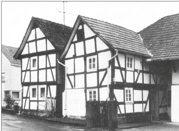
Die beiden Häuser Am Lehngarten 2 und 4. Aufnahme aus der Denkmaltopographie.
