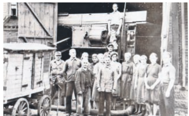
Modernisierte Dreschmaschine in Niederaula mit Körnergebläse und mit Elektromotor angetrieben (Archiv Hans Hartwig).
