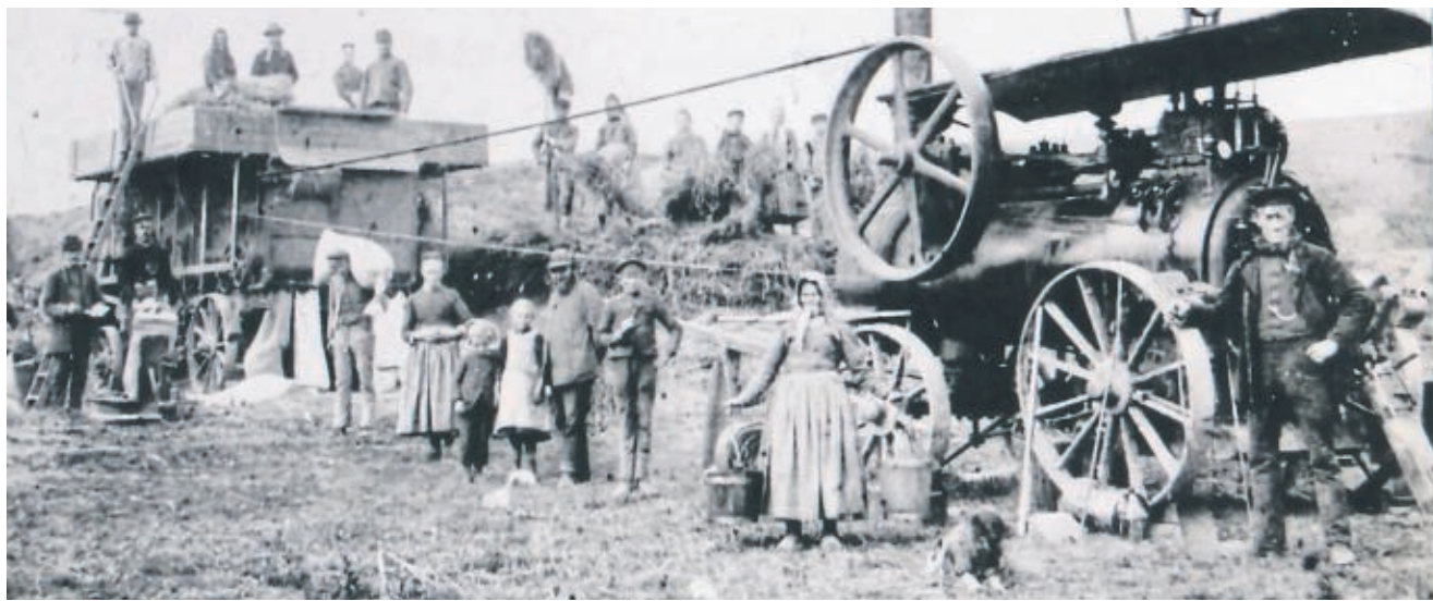
Dreschtag in Breitenbach-Gehau 1897: Dreschmaschine mit Dampfkesselantrieb (Archiv Heinrich Thamer).
