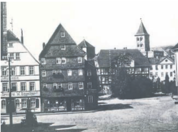
6: Fachwerk-Haus Hirschberger am Linggplatz und links daneben die Stiftsschänke.
