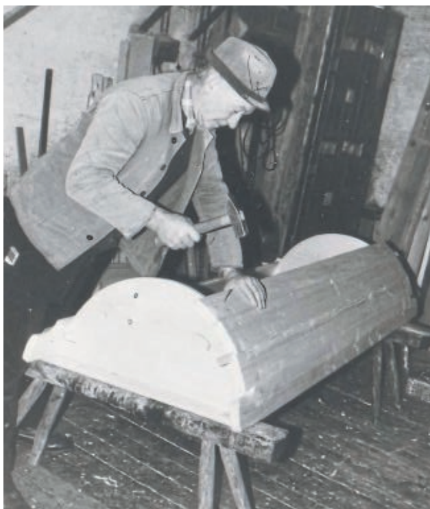
Stellmacher Heinrich Schneider , Gershausen, beim Anfertigen eines Schlachttröges (Aufnahme Miehe um 1980).
