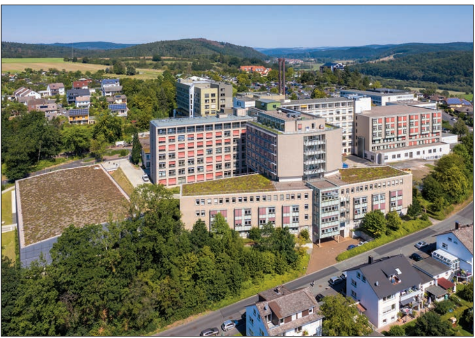
Klinikum Bad Hersfeld, 2019, links das Parkhaus.
