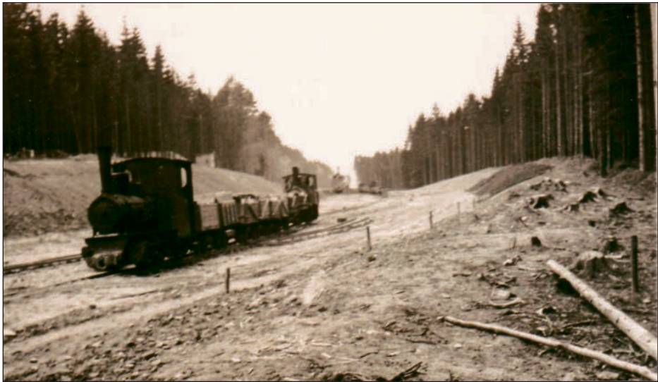
Bau der Reichsautobahn in der Gemarkung Kathus mit Hilfe einer Feldbahn (ab 1938).
