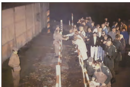
Maueröffnung an der Werrabrücke bei Philippssthal in der Nacht vom 11. auf den 12. November 1989.
