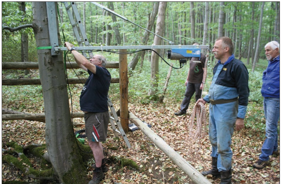
Vorbereitung der Müllräumaktion mit dem elektrischen Flaschenzug.
