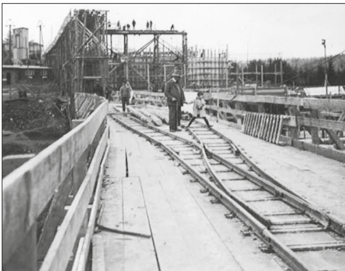
1939: Die Siebenborn-Brücke wurde im Rahmen der Neugestaltung der BAB 4 überflüssig und deshalb rückgebaut.
