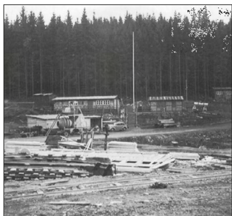
1938: Baubaracken mit Fahnenmast, Betonmischer, Feldbahngleise.
