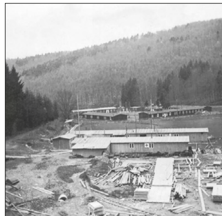
Das Breitzbachlager: Deutlich zu erkennen ist die detaillierte Planung einer solchen Anlage und die industrielle Fertigung der Einzelteile für die Einheitsbaracken.
