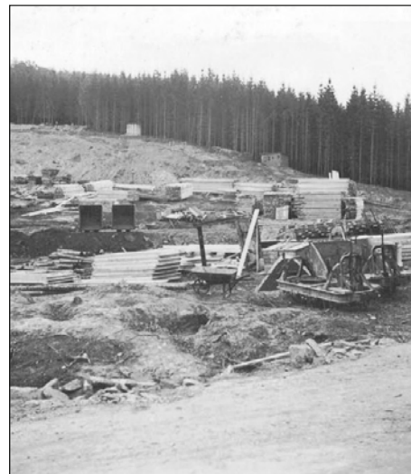
1938: Bildmitte: Feldbahnloren wurden von Hand für den Erdmassenausgleich und Materialtransport verwendet. Im Vordergrund Rodungslöcher des ehemaligen Baumbestands.
