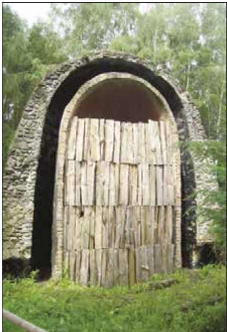
Teerofen-Rekonstruktion bei Jena, 4 m hoch. (Aufnahme Freudenstein)
