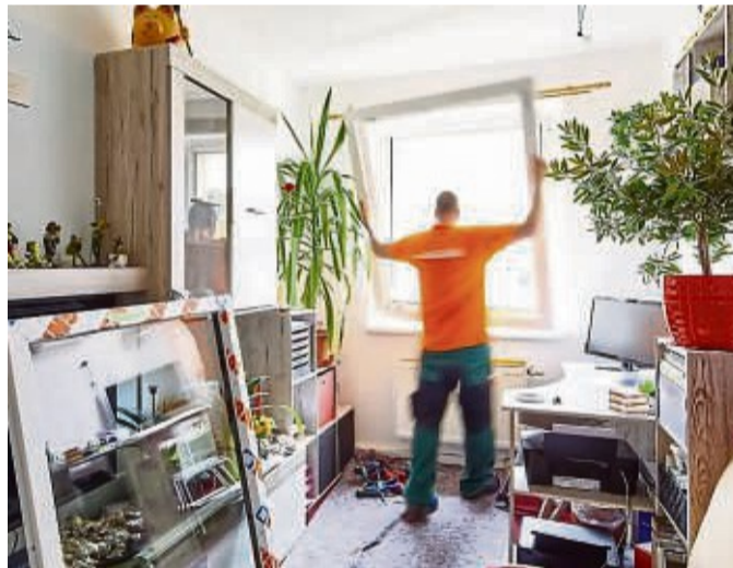
Fensteraustausch ist Expertensache.
