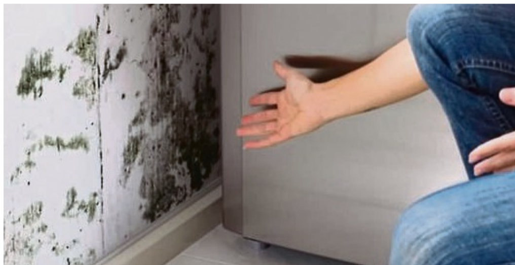
Die Firma Kimm ist ein kompetenter Partner für Wasserschadensanierungen.
