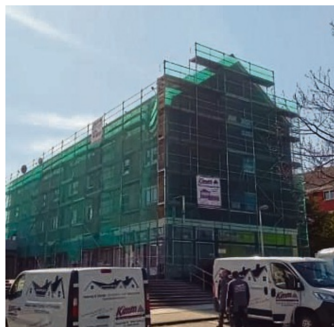
Vom Keller bis zum Dach: Meisterliche Arbeiten rund um das Haus bietet die Firma Kimm aus einer Hand.
