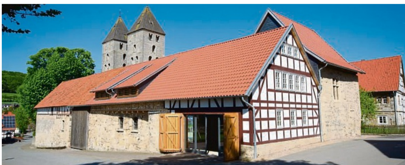
Der weitere Ausbau der Gebäude ist in Planung: Die Machbarkeitsstudie zur Entwicklung des Flechtendorfer Klosters hält eine minimale Sanierung ab rund vier Millionen Euro für möglich. Foto: pr
