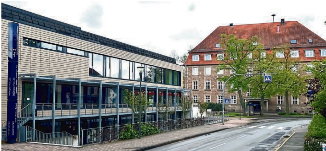
Blick auf Rathaus und Bürgerhaus an der Rathausstraße: Ein Brandschutzgutachten hat ergeben, dass die zehn Arbeitsplätze in sieben Büros im Dachgeschoss des Rathauses nicht weiter bestehen dürfen. Sie sollen in das Obergeschoss des Bürgerhauses umziehen. Hier waren bisher Klassenräume der Kreisvolkshochschule untergebracht. FOTO: ELMAR SCHULTEN
