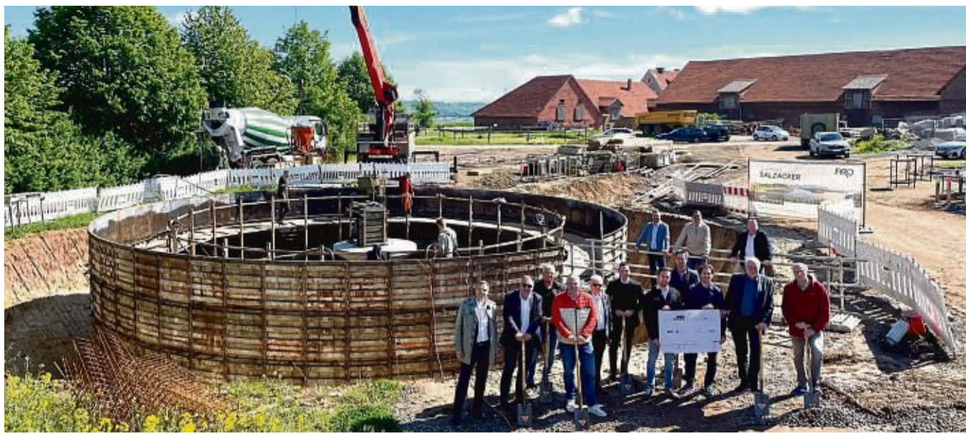
Ein „Leuchtturmprojekt“: Symbolischer Spatenstich für die Heizzentrale. Herzstück des Neubaugebietes „Salzäcker“ ohne Gasanbindung wird ein Nahwärmenetz mit Eis-Energiespeicher und Wärmepumpen. FOTO: CONNY HÖHNE
