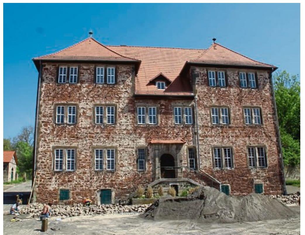
Geschichtsträchtiges Gebäude: Das Herrenhaus der Staatsdomäne Mittelhof, Ziel von Führungen des Heiligenbergvereins. Der Bau aus Naturstein steht seit vielen Jahren leer. Der Hof wird derzeit mit den alten Natursteinen neu gepflastert.
