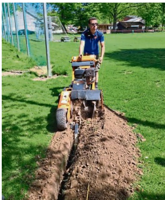
Der Graben für die Wühlmaussperre: Alexander Sporr an der Bodenfräse.
