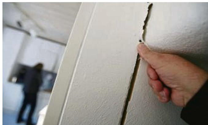
Eine schlechte Bauausführung, minderwertige Materialien oder Fehler bei der Planung können zu solchen Rissen führen.
