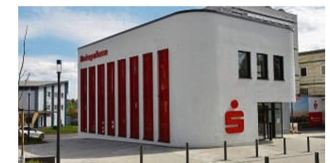
Das neue Beratungsgebäude der Kreissparkasse.
