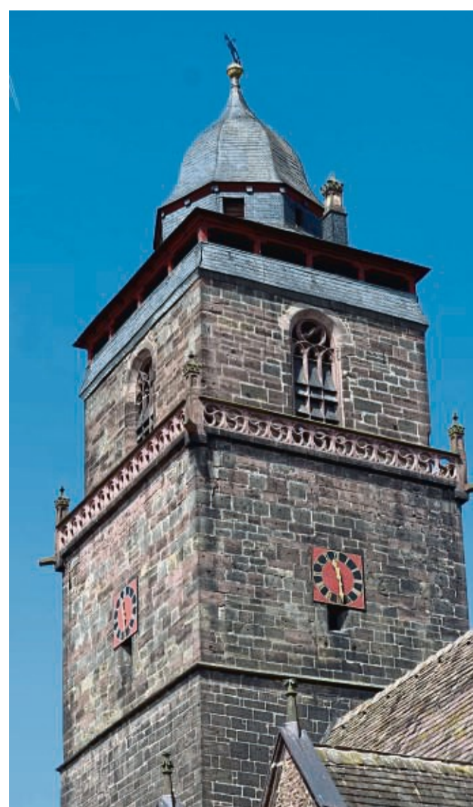
Vom höchsten Kirchturm im Kirchenkreis Hofgeismar-Wolfhagen, der dann bald eingerüstet wird, ist demnächst vielleicht nur noch ein wenig der Welschen Haube zu sehen.
