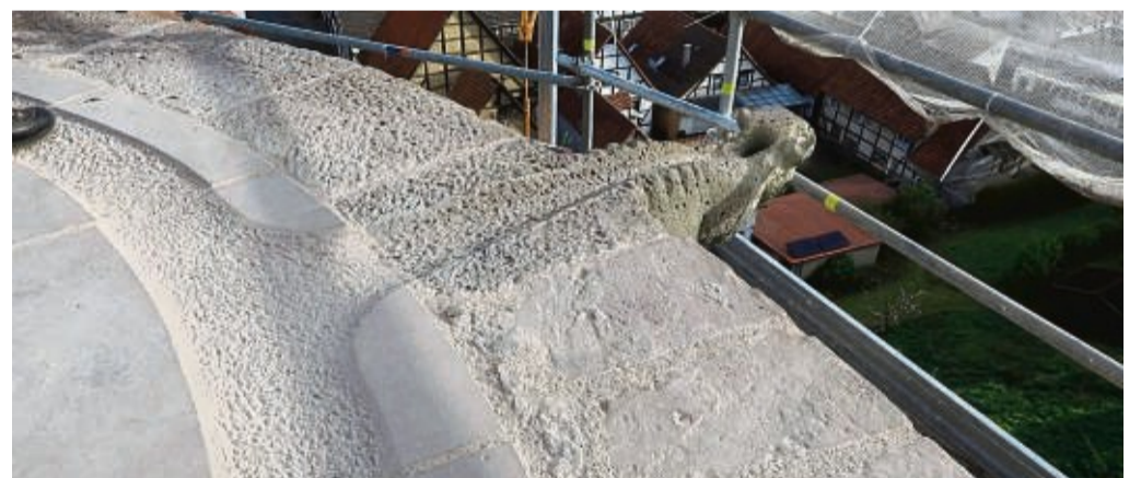
Die ganze Spitze des Turmes wurde erneuert, auch die Wasserrinne und Teile der Wasserspeier. FOTOS: THOMAS THIELE
