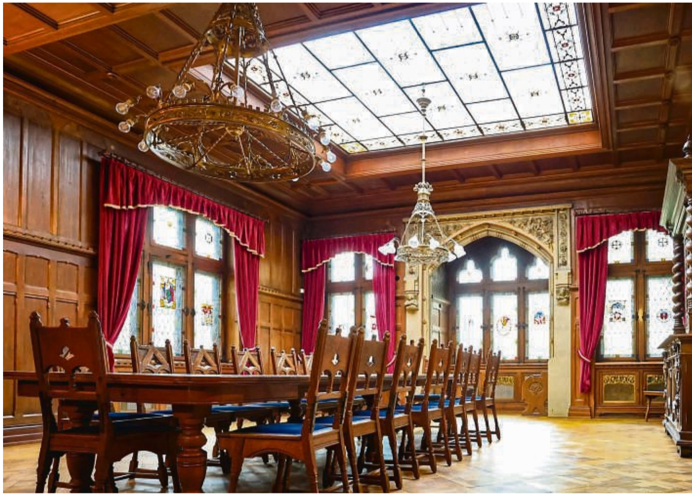
Erstrahlt in neuem Glanz: Der Speisesaal auf Schloss Rothstein konnte gerettet werden. Der Kampf gegen den Hausschwamm wurde mit handwerklichem Geschick und moderner Mikrowellen-Technik gewonnen. FOTO: KONSTANTIN MENNECKE
