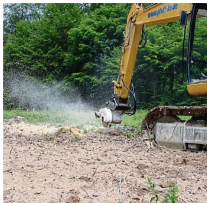
Die Späne fliegen: Für spätere Rangierflächen zu Baufeldern werden Baumstümpfe gerodet.
