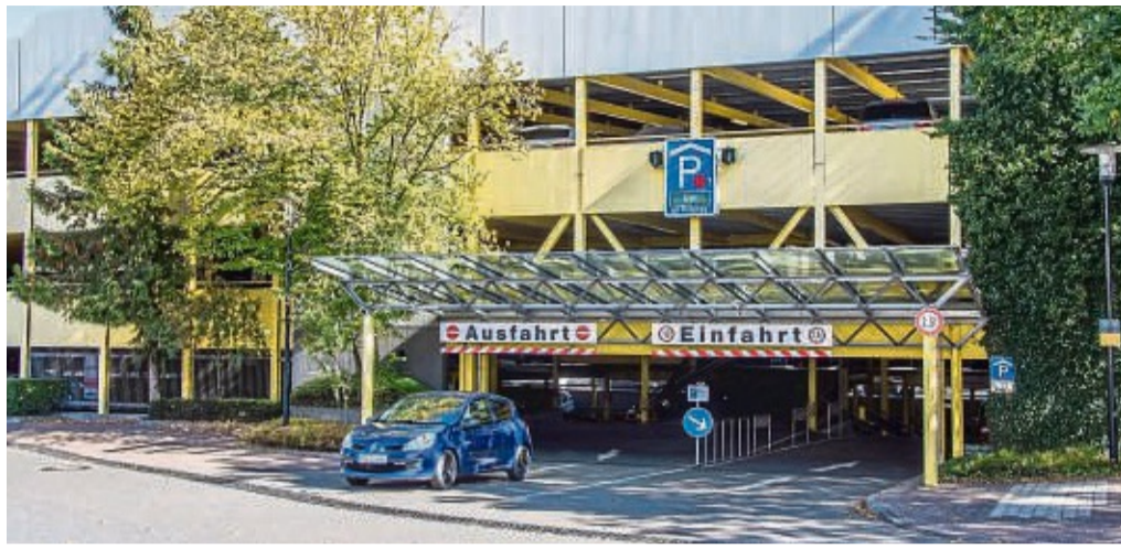
Das städtische Parkhaus in der Flechtdorfer Straße bekommt doch kein Photovoltaik-Dach.
