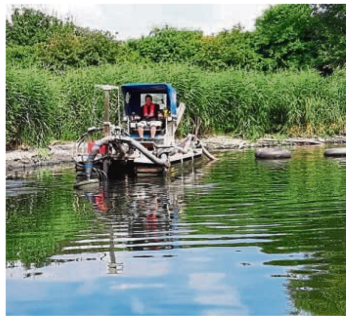
Entschlammung mittels Saugbagger. SYMBOLFOTO: AMODES
