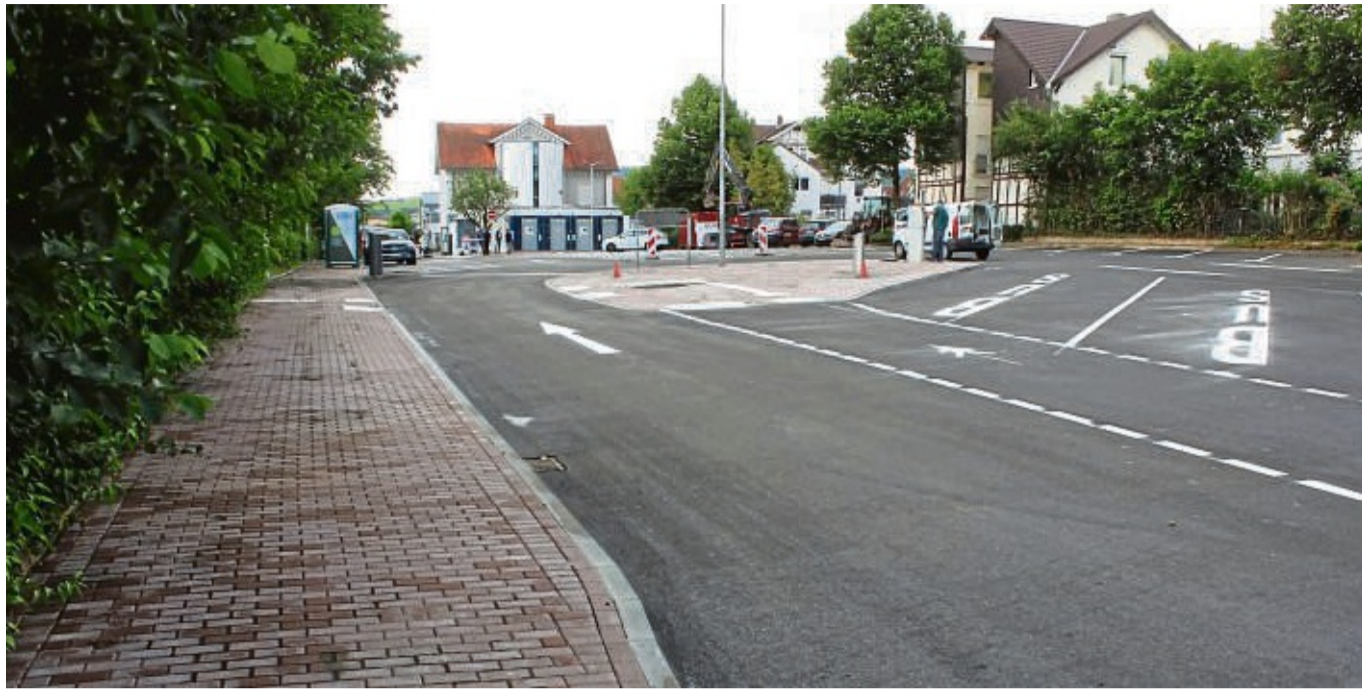
Der Parkplatz hat erstmals einen Fußweg erhalten. Wo aktuell noch der Baucontainer steht, werden bald E-Bike-Boxen und -Ladesäulen montiert. FOTO: SCHULDIT
