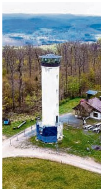
Der Kaiser-Wilhelm-Turm auf der Sackpfeife ist dringend sanierungsbedürftig. ARCHIVFOTO: MARK ADEL/INH
