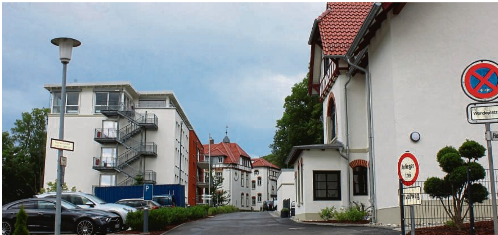
Blick auf das Psychiatrische Pflegezentrum Werrablick. Vor Kurzem wurde das neue Therapiezentrum, das aus einem sanierten Altbau aus dem Jahr 1904 mit einem modernen Anbau besteht (vorne rechts im Bild) eingeweiht.
