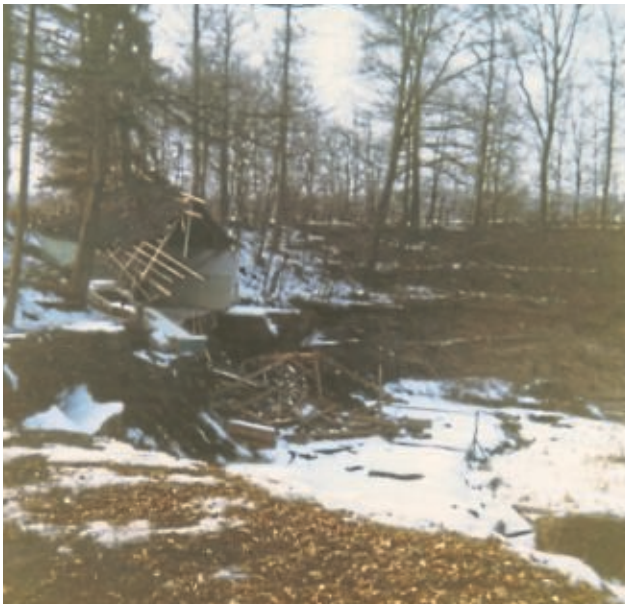
Bild 2: Zerstörtes Schützenhaus – fotografiert im Februar 1969.
