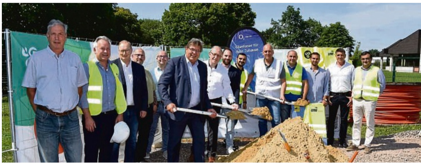
Freuen sich mit Mitarbeitern der Stadtverwaltung und der beteiligten Unternehmen über den Start des Glasfaserausbaus in Korbach: Bürgermeister Klaus Friedrich (6. von links), die UGG-Mitarbeiter Ralf Stratmann (daneben) und Ralph Wehberg (5. von links) sowie Jürgen Jansen von aus ausführenden Baufirma CME Deutschland GmbH. FOTOS: DAUM
