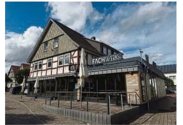
Das Team vom „Fachwerk 1670“ in Sachsenhausen freut sich auf viele Besucher. FOTO: FACHWERK 1670
