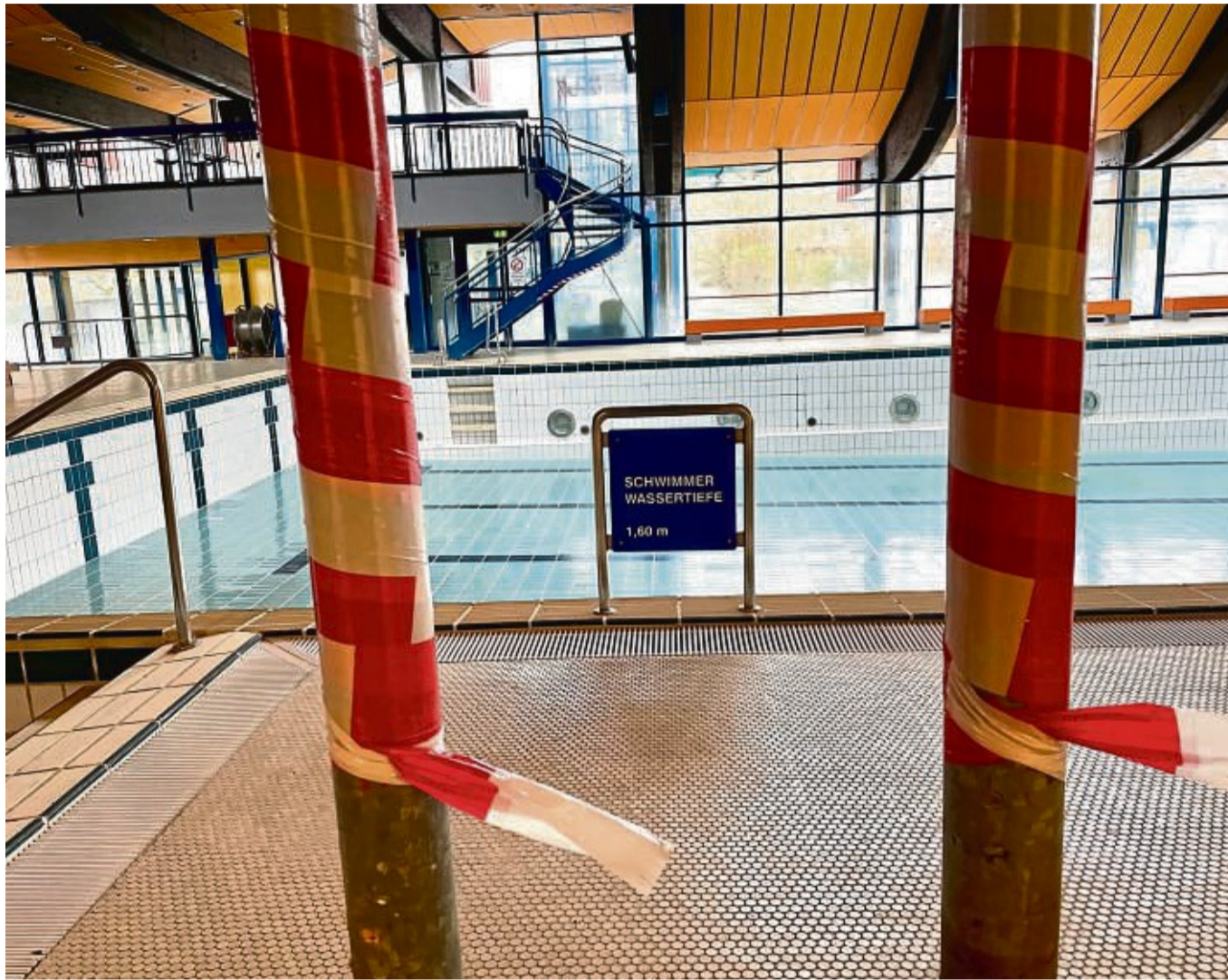
Decken abgestützt , Schwimmbecken leer: Für das Heloponte liegt die Abrissgenehmigung rund ein halbes Jahr nach Antragstellung durch die Stadt vor. Nun folgt die europaweite Ausschreibung.
