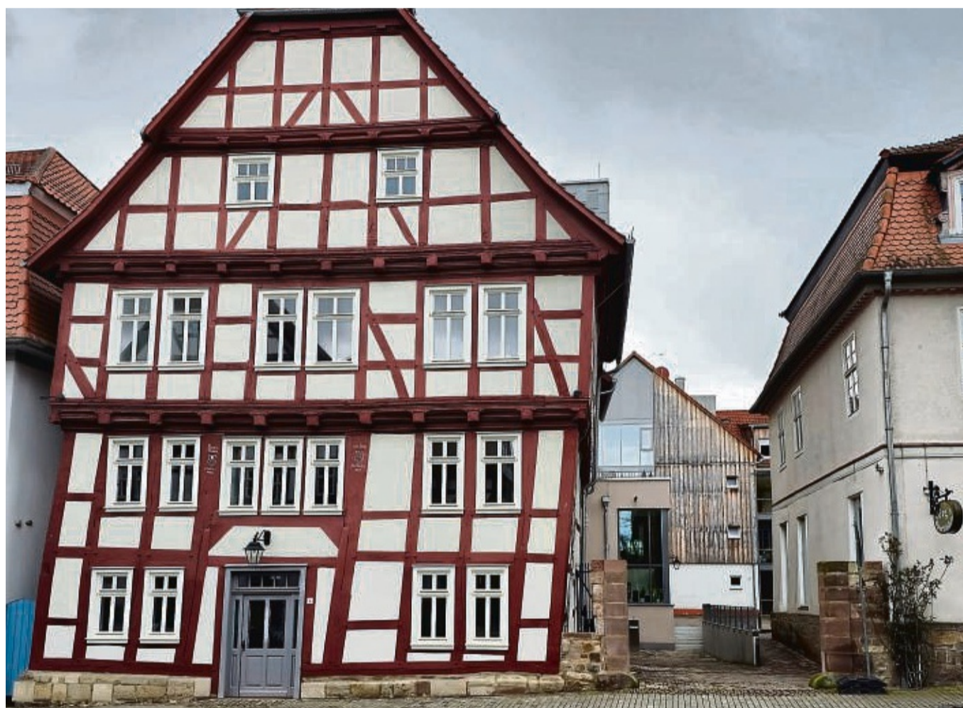
Im Haus Marktstraße 28 in Grebenstein, dessen geplante Nutzung nicht zustande kam, entstehen 28 Büros für mobiles Arbeiten in Heimatnähe.
