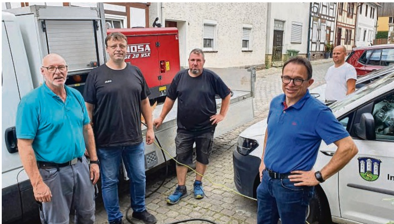
Notstromaggregat am Rathaus getestet: Erleichtert über den erfolgreichen Test sind (von links): Karl-Werner Fehling (Firma Fehling-Tec), Dirk Reinhardt (Stadt Immenhausen), Björn Lezius (ZKD Immenhausen-Espenau), Bürgermeister Lars Obermann und Dennis Aßhauer (ZKD).
