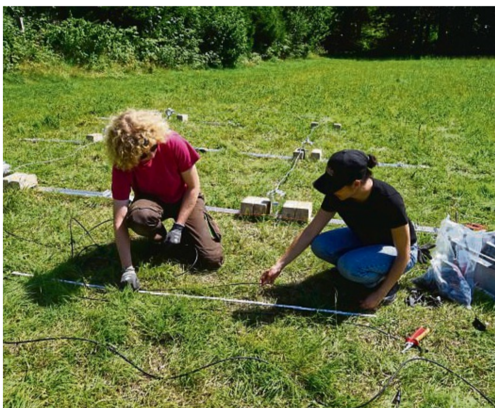
Dana und Sofia üben die Installation von PV-Anlagen auf einem simulierten Flachdach.
