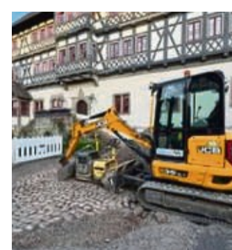
In Arbeit: Mit der Sanierung des Schlosshofes ist begonnen worden. FOTO: WERNER KELLER
