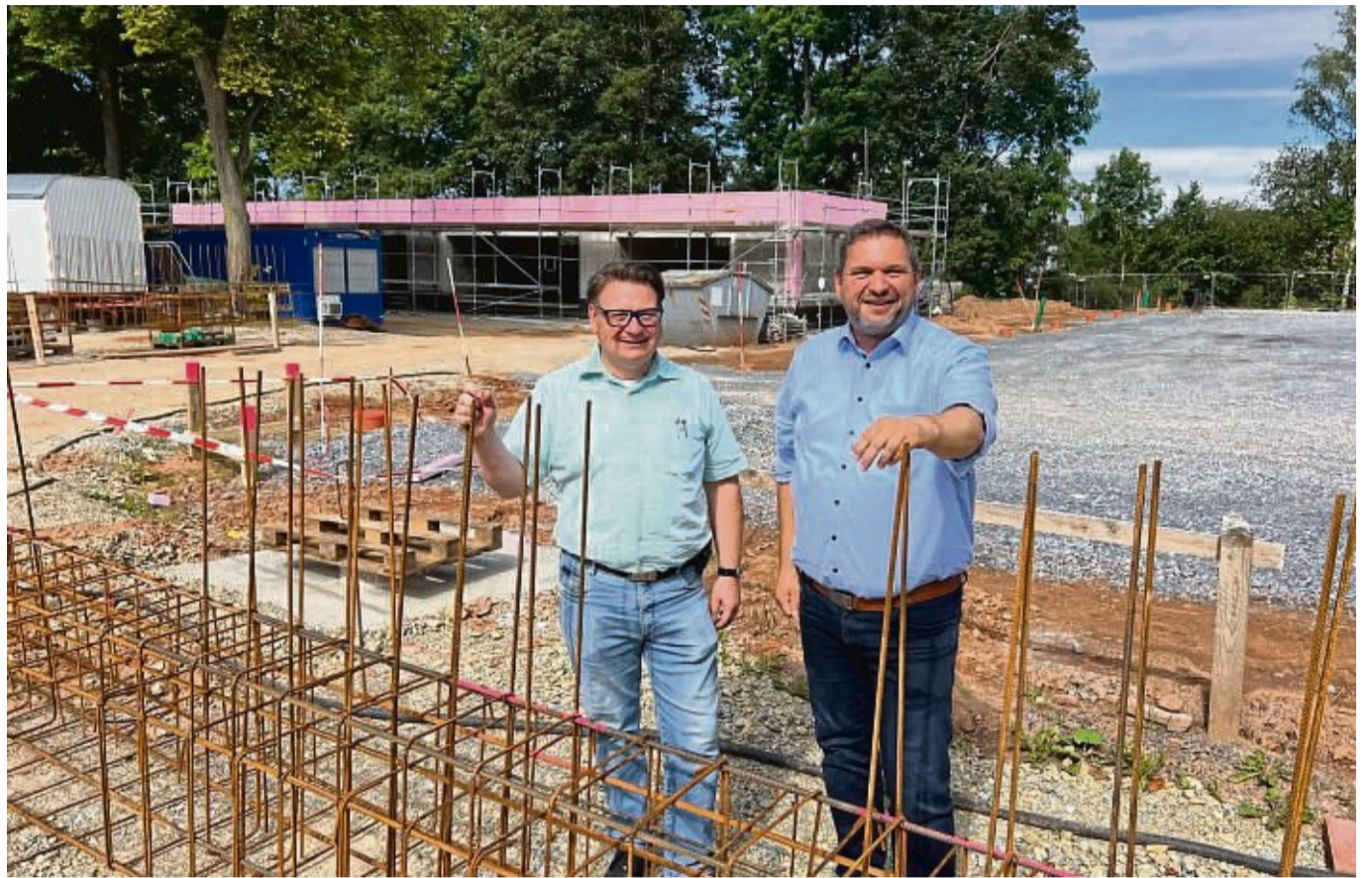
Baustellenbesichtigung: Bürgermeister Marco Lambion und der stellvertretende Bauamtsleiter Marco Tröger im Richard-Beekmann-Stadion.
