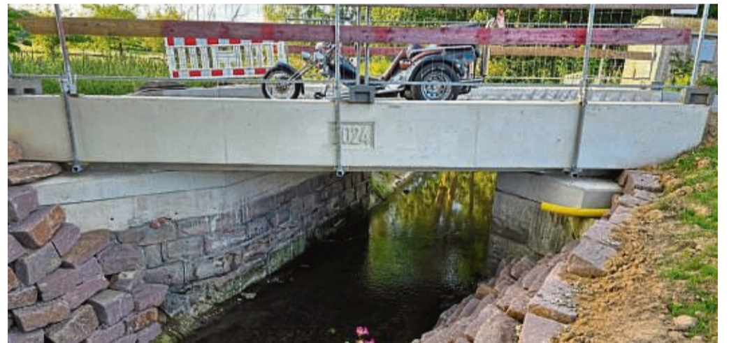
Bekommt in wenigen Wochen ein Geländer: Die restaurierte Brücke über die Warme im Rosengarten in Ehlen.
