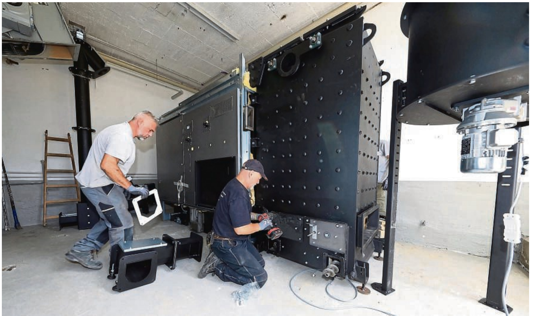
Eine Fachfirma aus Österreich begann am Dienstag mit der Montage unter anderem des Brenners.
