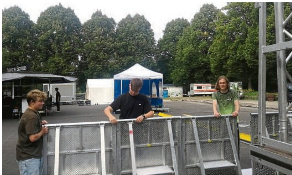
Auf dem Freizeitgelände in Hessisch Lichtenau fanden gestern noch die letzten Aufbauarbeiten für das Holle-Rock-Festival statt, unser Bild zeigt die Helfer (von links) Anton Klinge, Luca-Noel Liese und Julian Eberling an den Bühnenbarrikaden. Beim Festival im nächsten Jahr soll den Besuchern ein Toilettencontainer zur Verfügung stehen. FOTO: LOTHAR RÖSS
