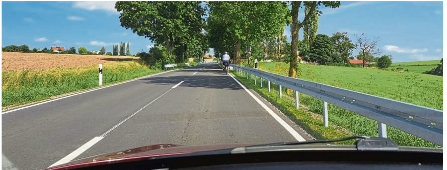
Für Verdross sorgen die vielen zusätzlichen Leitplanken, die zwischen Goddelsheim, Rhadern (unser Bild) und Dalwigksthäl mit der Sanierung der Landesstraße aufgestellt wurden. Die Straße wird enger.
