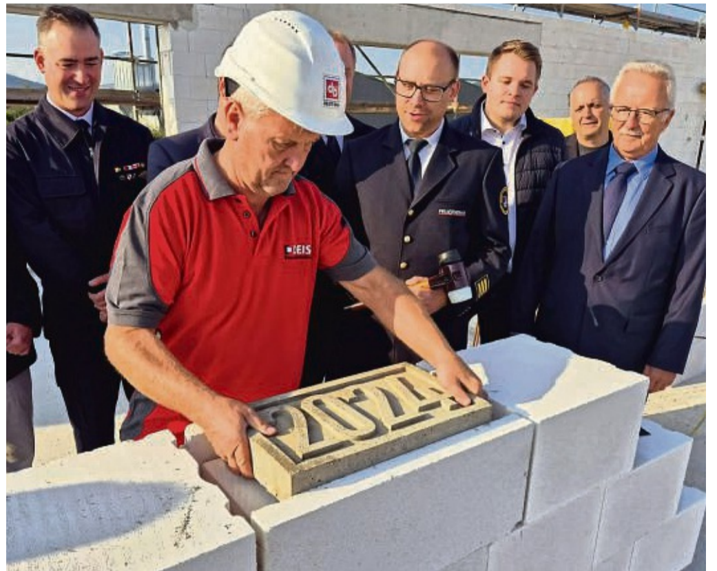
In den Grundstein wurde eine Zeitkapsel eingelassen – sie beinhaltet sämtliche Beschlüsse der Wehretaler Gemeindevertretung zum Bau, das Ergebnis der Kommunalwahl 2021, den Zuwendungsbescheid des Landes Hessen sowie die Werra-Rundschau vom Freitag, 20. September. FOTO: EMILY HARTMANN
