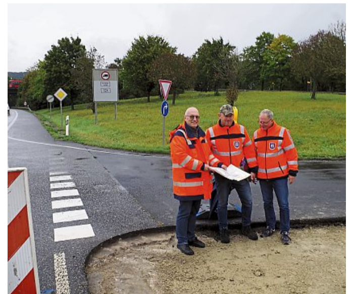
Die Verkehrsinseln sind schon weg: Hessen-Mobil Mitarbeiter Markus Wagner, Fachdezernent Bau Region Osthessen (von links), Maik Killmer von der Bauüberwachung und Stefan Morhardt, Sachgebietsleiter Ingenieurbauwerke/Erhaltung, an der Rampeauffahrt, die demnächst geteert wird.
