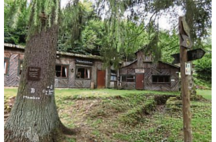
Das sanierungsbedürftige Ausflugsziel Waldschlößchen im Fahrachtal muss nicht abgerissen werden. Ein Verein, der derzeit gegründet wird, übernimmt die Gaststätte.
