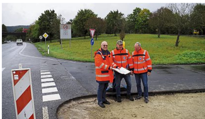
Die Verkehrsinseln sind schon weg: Hessen-Mobil Mitarbeiter Markus Wagner, Fachdezernent Bau Region Osthessen (von links), Maik Killmer von der Bauüberwachung und Stefan Morhardt, Sachgebietsleiter Ingenieurbauwerke/Erhaltung, an der Rampeauffahrt, die demnächst geteert wird.
